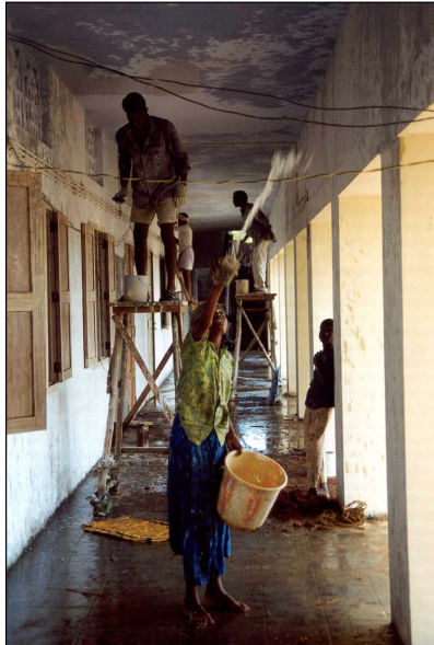
Die Decke wird gestrichen
