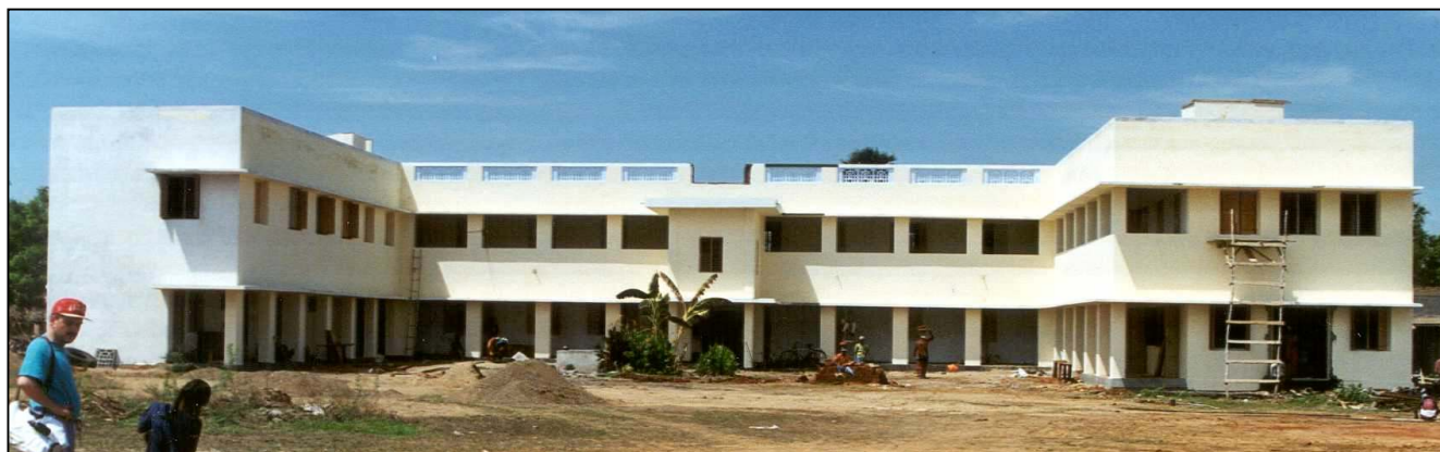
Der fertige Schulbau in seiner vollen Größe
